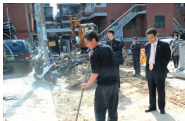
중화동 326번지 일대 하수관 교체공사 현장을 방문한 이성민 의장
