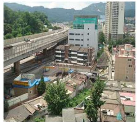
<성북구 정릉동 희망하우징 공사>
