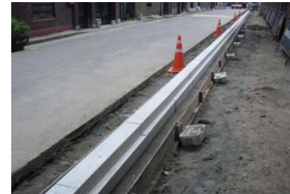
침하방지용 경계석 설치
