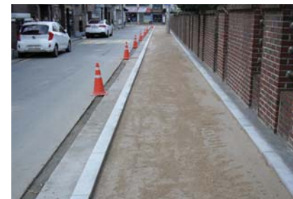
시공선에 의한 모래 포설
