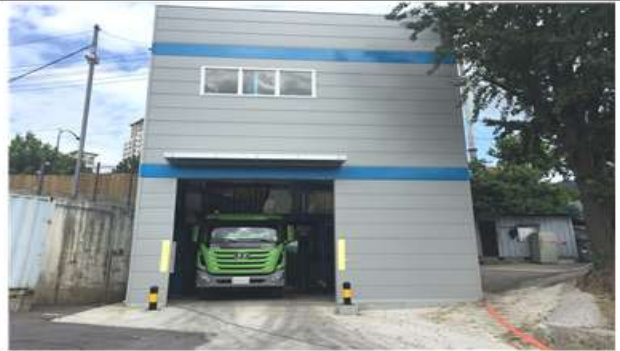
음식물류폐기물 집하시설 정비 후
