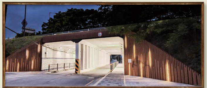
4호 안새우개 굴다리 심플렉스 북부 간선도로 하부 터널 입면
