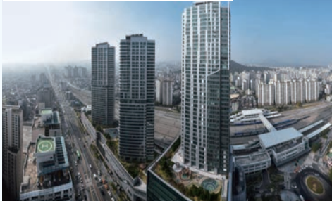
현재 상봉프리미어스엠코 전경
