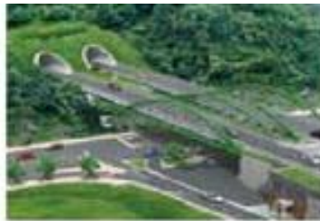
용마터널 종점부(구리시 아천동)
