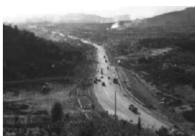
망우리 도로 확장공사 (1972년, 서울사진아카이브)
